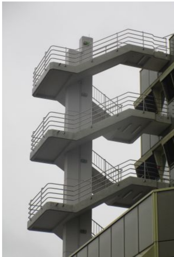
Freitreppen des A-1-Telekom-Gebäudes
