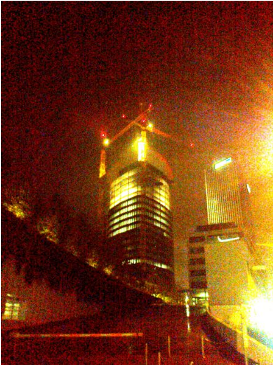
Hochhaus im Bau in Wien, nachts, mit falschen Farben
