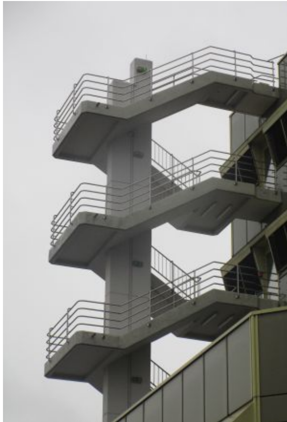
Freitreppen des A-1-Telekom-Gebäudes
